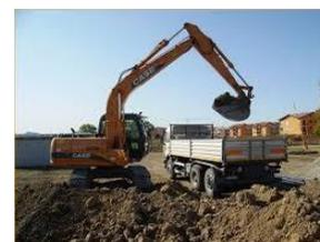
Per realizzare quanto esposto si adottano delle tipologie di scavi distinte: scavo di sbancamento, scavi a sezione obbligata. Per entrambe le tipologie sono stati analizzati rischi connessi.
